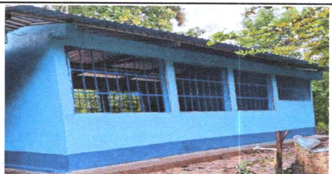
Foto 6: Remodelacion del modulo del nivel preprimario, se observa el repello y pintura en paredes interiores y exteriores
