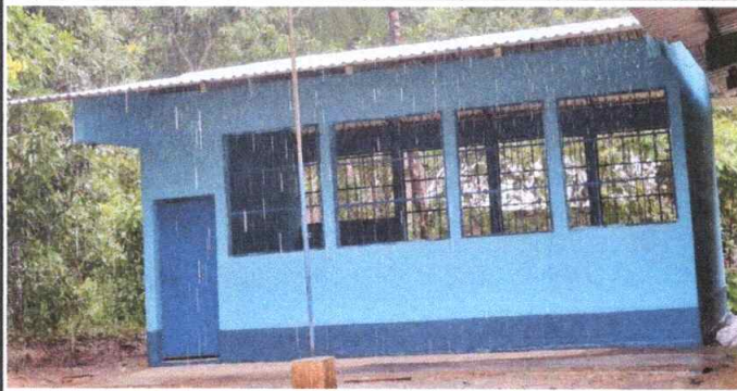
Foto1: Se observa el techo instalado del establecimiento.
