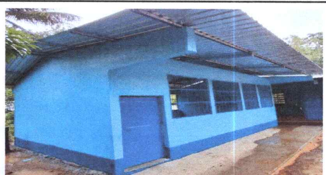
Foto 4: Se observa que se instalaron los balcones en el modulo
